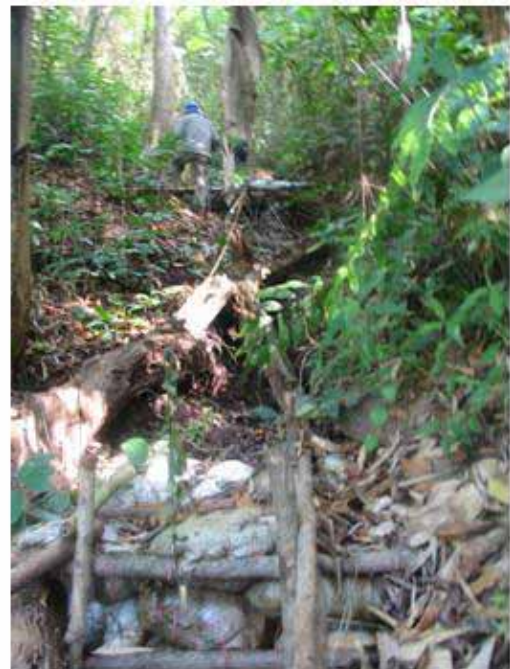
ฝายต้นน้ำแบบผสมผสานที่ราษฎรในพื้นที่ มีส่วนร่วมในการกำหนดพื้นที่สร้าง
