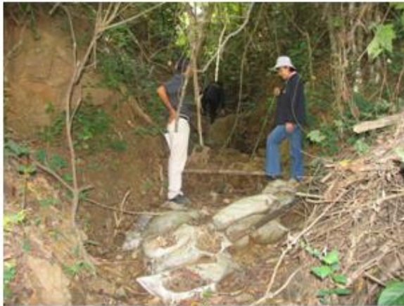
ฝายต้นน้ำแบบผสมผสานมีสภาพชำรุดเนื่องจากถูกน้ำป่าไหลหลาก
